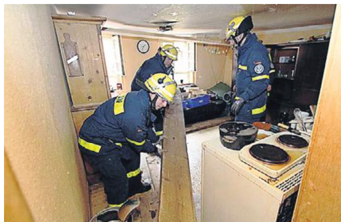
Das THW sichert die Wohnungsdecken in der ersten Etage ab.
