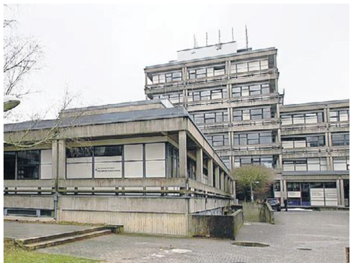
In der Hans-Meerwein-Straße ist der Fachbereich Chemie untergebracht. Im Gebäudeteil J trat das Wasser aus.
