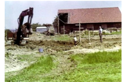
Spatenstich neuer Feuerwehrstützpunkt
