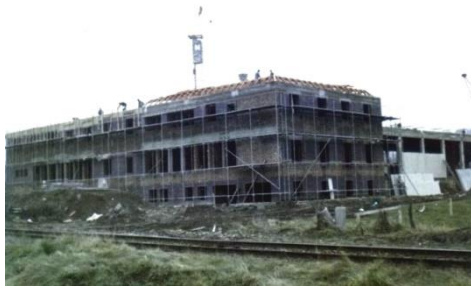
1971 - Rohbau fast fertig
