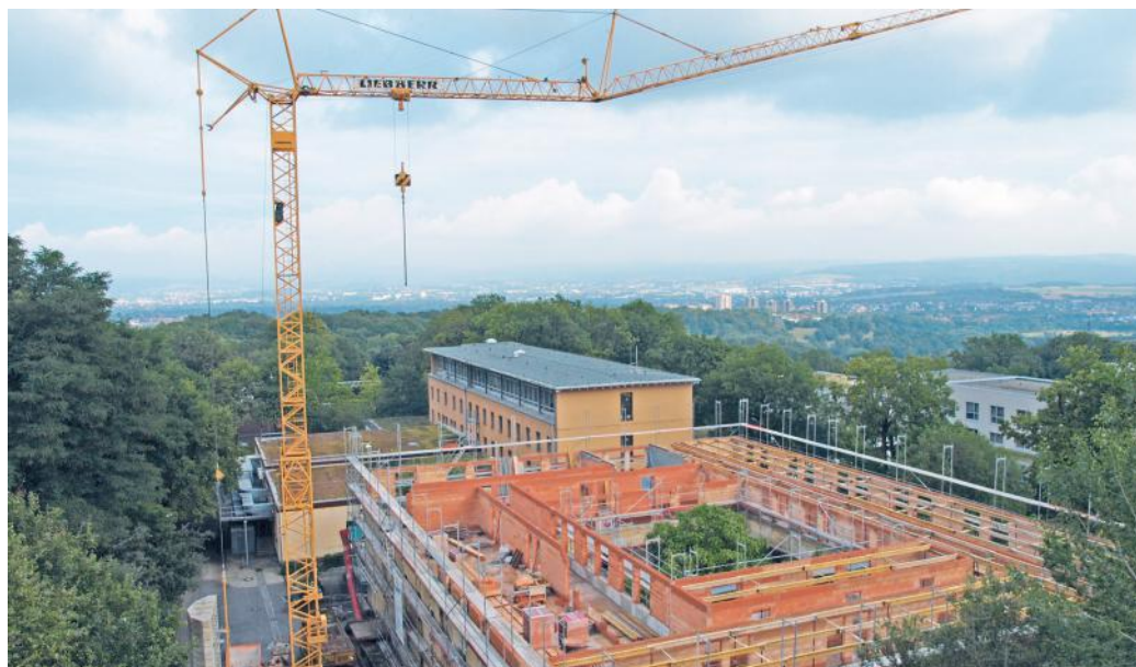
Blick von der Drehleiter auf die Baustelle.
