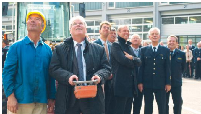
Staatssekretär Werner Koch setzt mit Hilfe der Fernbedienung des Kranes die Steine auf den 2. Stock des Gebäudes.
