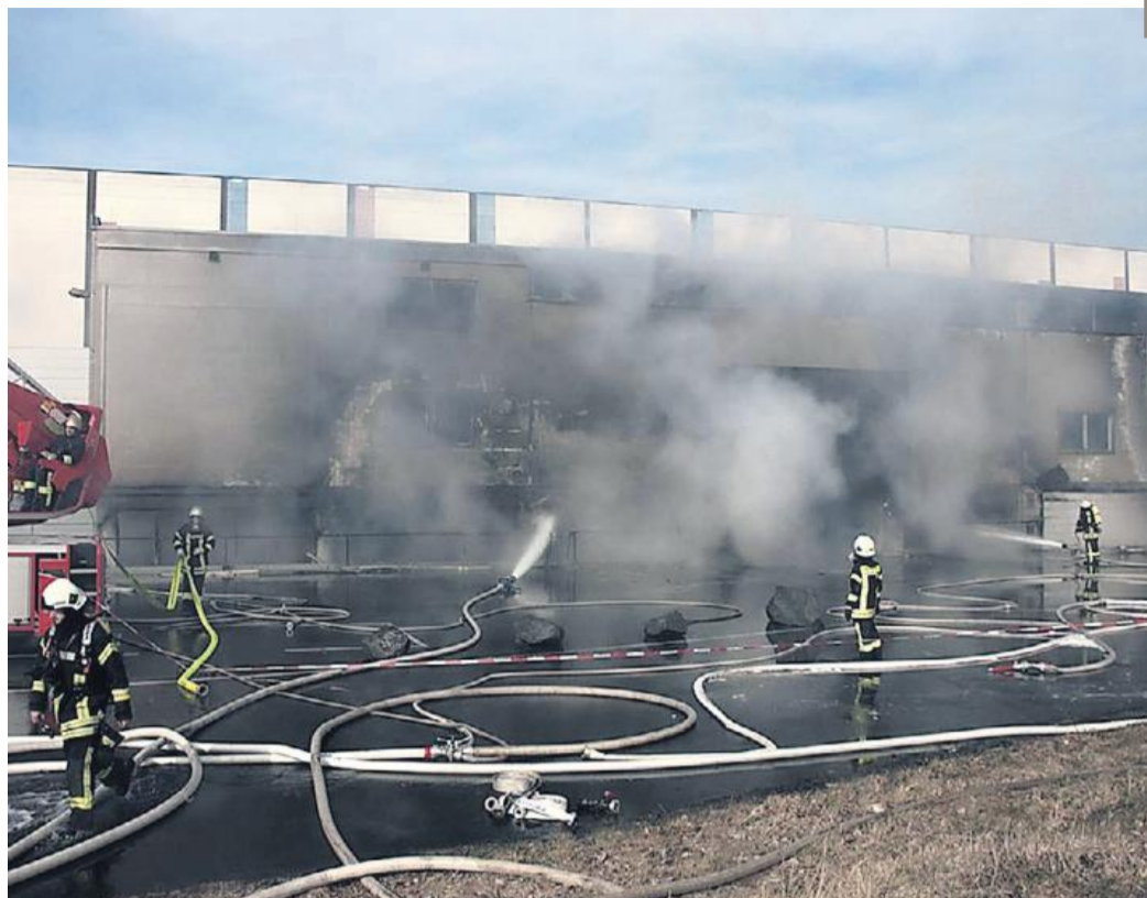
Ab dem Mittag konnte die Feuerwehr den Brand in der Druckereihalle nur noch von außen bekämpfen, weil das Gebäude einzustürzen drohte. Foto: Matthias Pfaff/Feuerwehr
