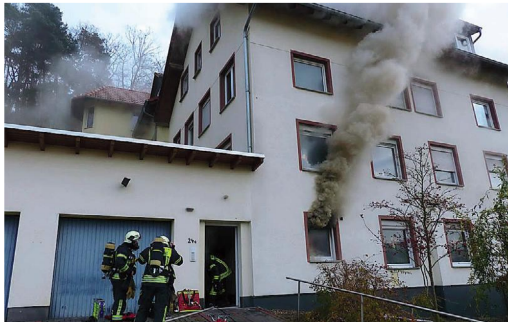
Starker Rauch stieg aus dem Fenster der Teeküche.
