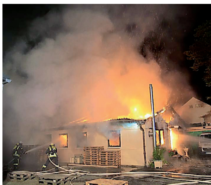
Feuerwehrleute bekämpfen die Flammen, die aus dem Bürogebäude schlagen. Foto: Matthias Pfaff/Feuerwehr
