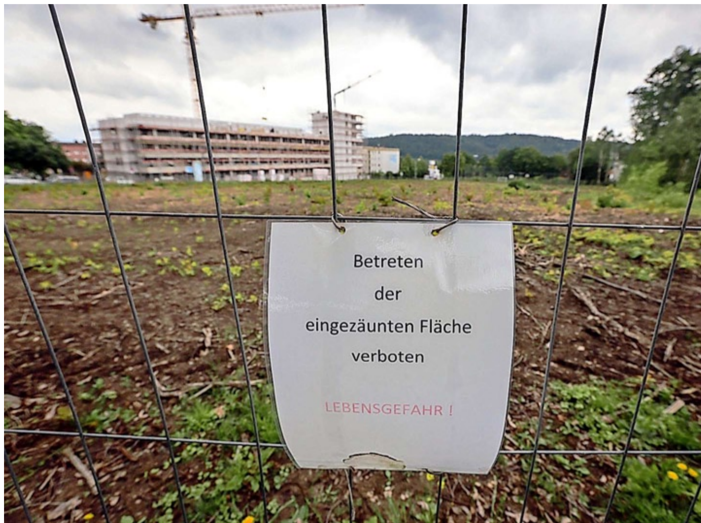
Das Baugebiet am Vitos-Park. Die Stadtverordnetenversammlung hat am Freitag ein Bürgerbegehren, das sich gegen die Teilbebauung des Parks wendet, als unzulässig zurückgewiesen. Foto: Thorsten Richter
