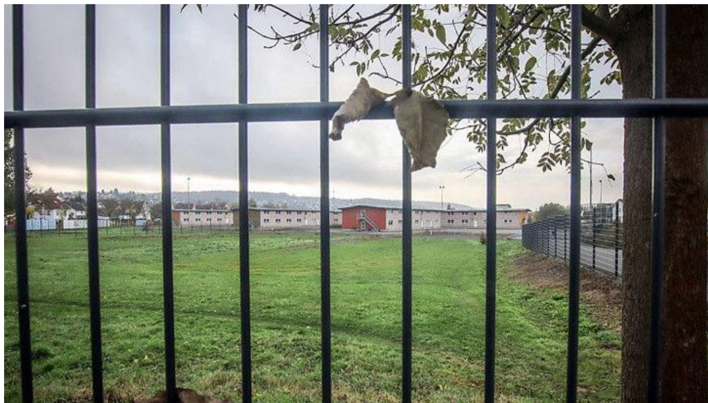
Die ehemalige Erstaufnahmeeinrichtung in Cappel: In den Geländeteil im Hintergrund soll die Landesfeuerweherschule einziehen, im Vordergrund ist der Neubau des Feuerwehrstützpunkts Cappel vorgesehen. Foto: Thorsten Richter
