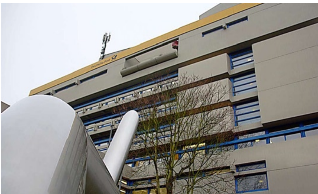
Das ehemalige Marburger Postamt, erbaut im Stil des sogenannten Brutalismus, steht seit zehn Jahren unter Denkmalschutz. Foto: Björn Wisker
