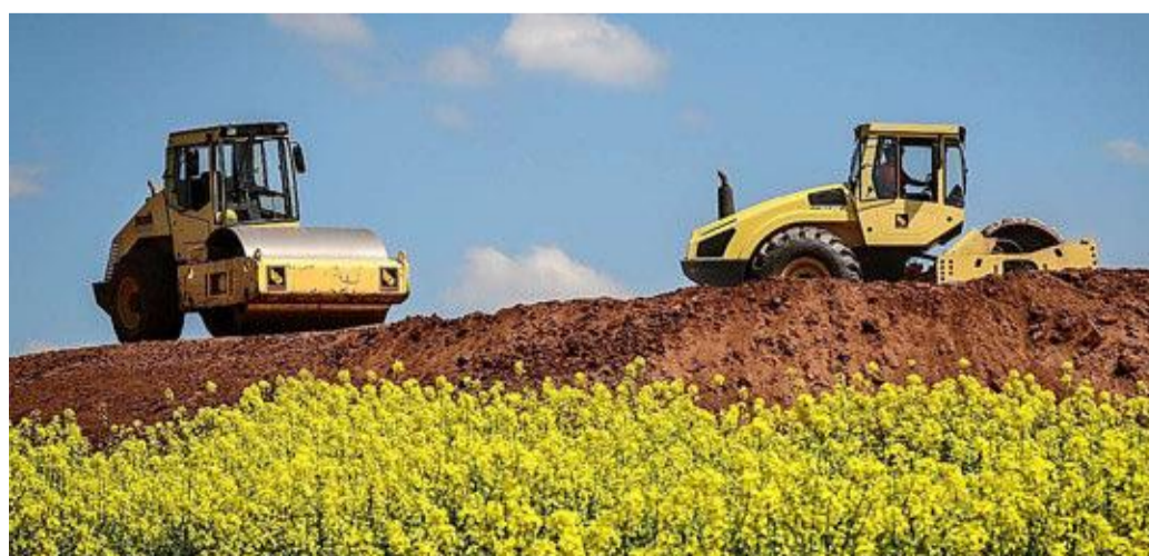
Die Arbeiten an der Ortsumgehung der B 252 dauern an.
